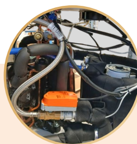
Optionales System mit elektronischem Druckventil Fintek-Patent mit intelligentem Algorithmus zur Anpassung an unterschiedliche Wassertemperaturen – für maximale Energieeinsparung.
